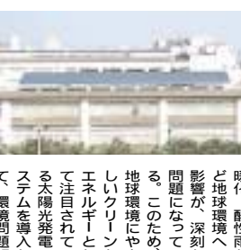
校舎屋上に設置された太陽光発電システム
