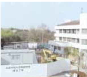
実験実習棟の施工現場(1月19日撮影。右は本館)
